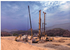
灌阳至平乐高速公路房建工程桩基础施工
