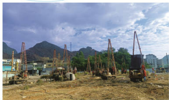
年产2.6亿副TPU覆层医用手套、自动化提升及节能减排项目施工勘察
