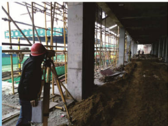
安厦·漓江大美桂林造纸厂地块项目（三期）
