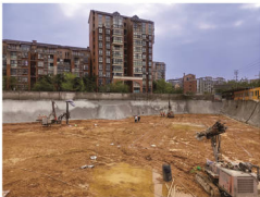
桂林中隐七号基坑支护工程及地基处理施工
